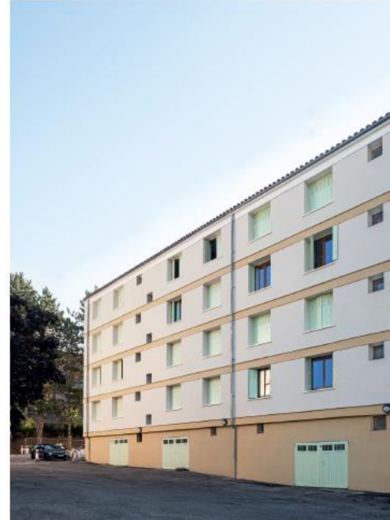
Photo: Façade Nord bâtiment N
