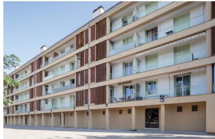
Photo: Façade Sud bâtiment O
