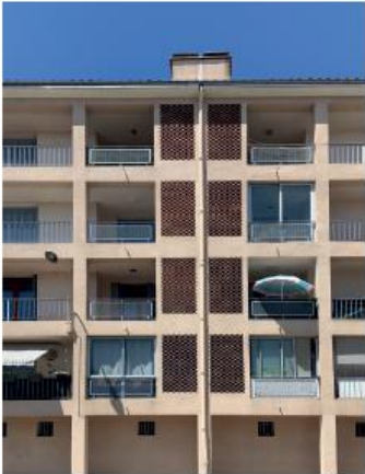
Photo: Avant travaux
