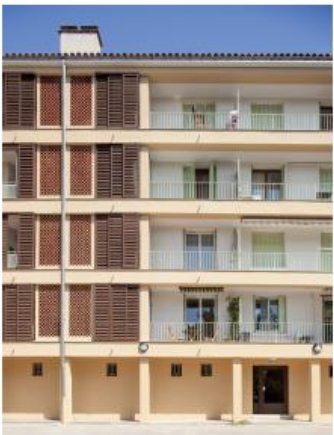
Photo: Après travaux
