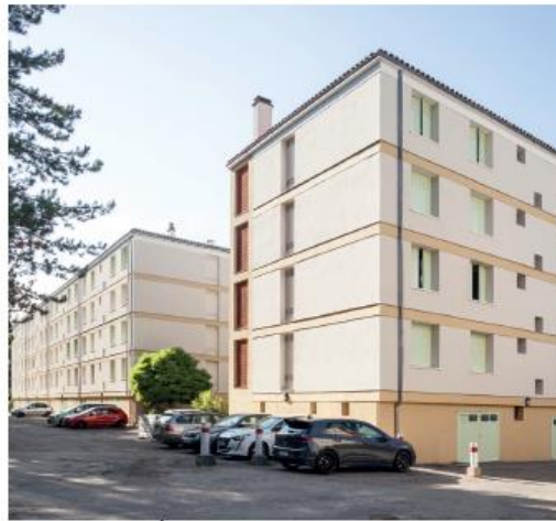
Photo: Façade nord bâtiment O et N
