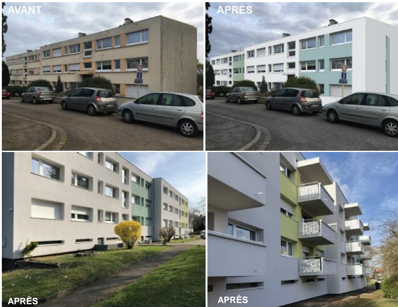
Rénovation thermique de la Copropriété "Les Frières", à Metz 57050
