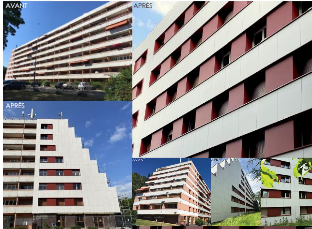
Bâtiment B, Parc de LIBREMONT, à MALZEVILLE 54220
